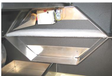
Dann sehen Sie die automatische Bypassklappe
